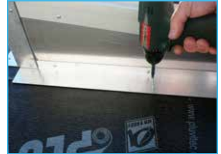
Schroef de flens vast
