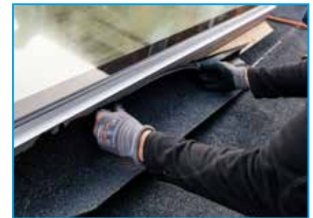
Aanbrengen dakbedekking
