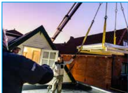
Plaatsen nabij raveling. Hijsstropen onder de pallet
