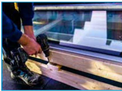
Losschroeven van de pallet
