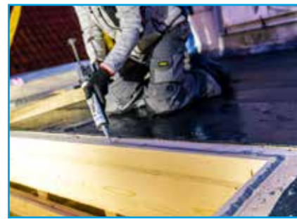
Aanbrengen kit op randbalk
