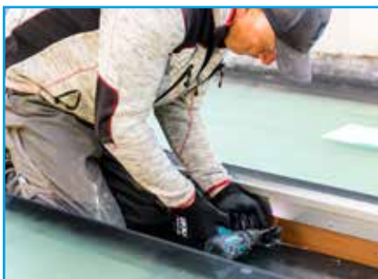
Vastzetten daklicht aan dakconstructie
