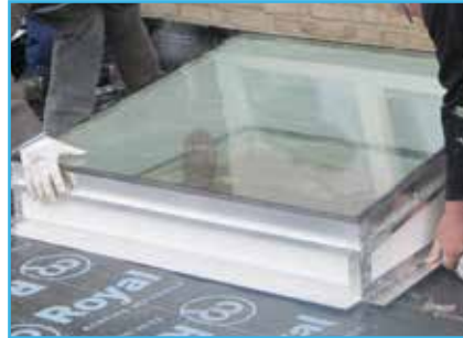
Plaats het element over de daksparing
