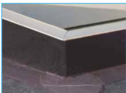
Breng de dakbedekking aan tot aan de aanslag
