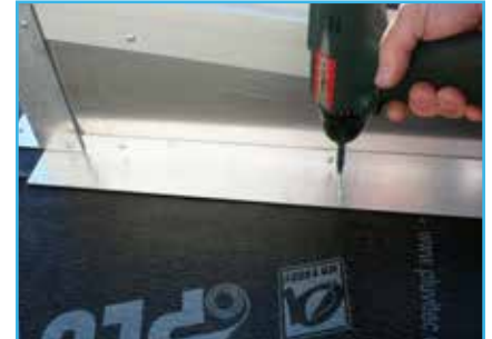
Schroef de flens vast
